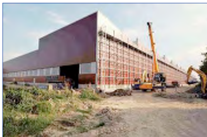
I lavori di ampliamento del capannone
